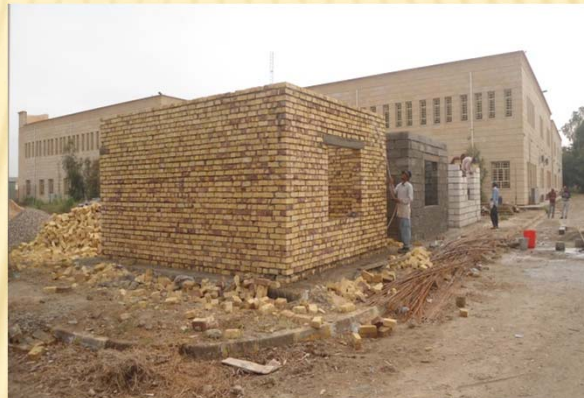
المعالجة بالماء ٣ ايام لاعمال البناء
