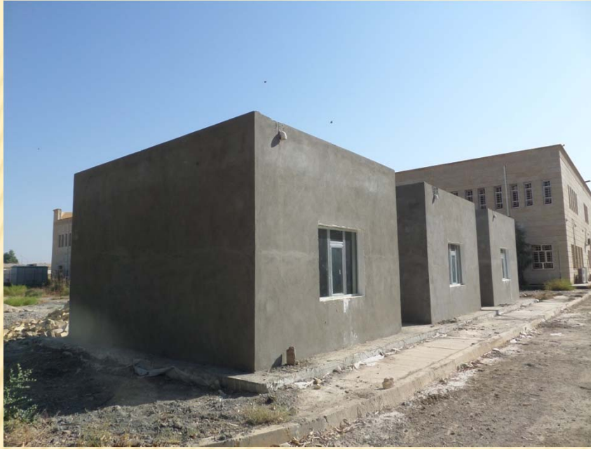
واجهة الغرف المواجهة للشمس
