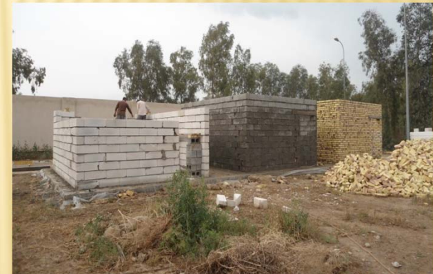
اعمال بناء الغرف الثلاثة
